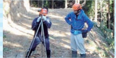
コンパスによる作業道の測量
