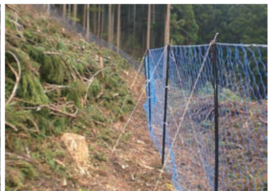
防護柵(ネット)
